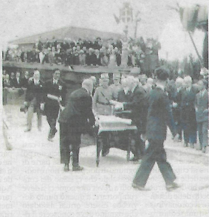
La posa della prima pietra della sede
